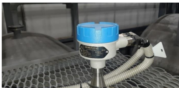
Рисунок 4 – Общий вид уровнемера ЭЛЕМЕР-УР-31
