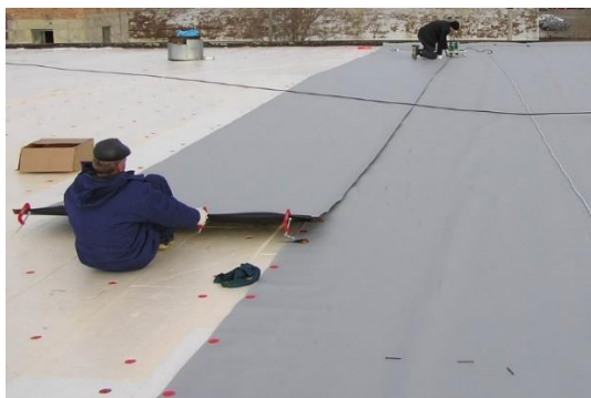
Рисунок 4 – Монтаж мембраны механическим способом
