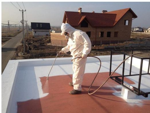
Рисунок 6 – Устройство кровли из жидкой резины
