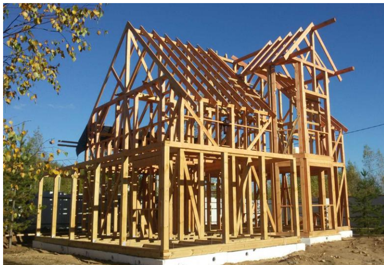
Рисунок 1 – Пример строительства каркасного дома
