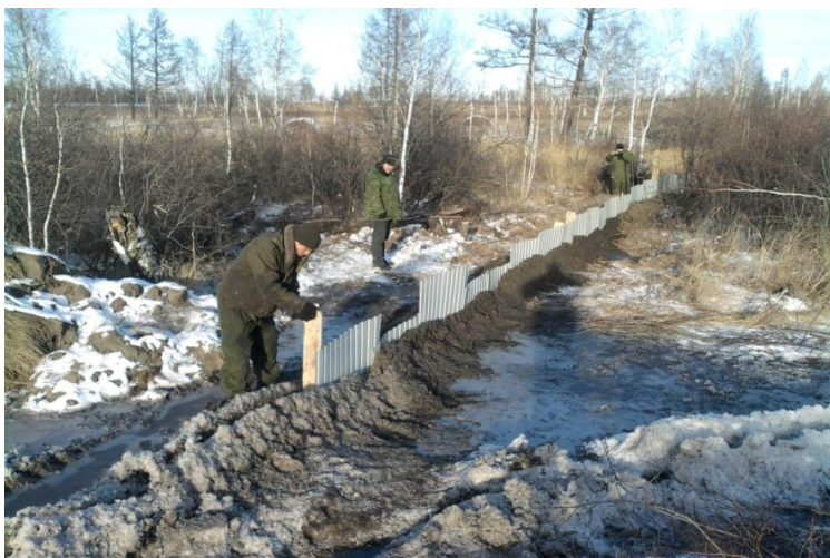
Рисунок 9 – Противofильтрационный экран, перехватывающий русло ручья
