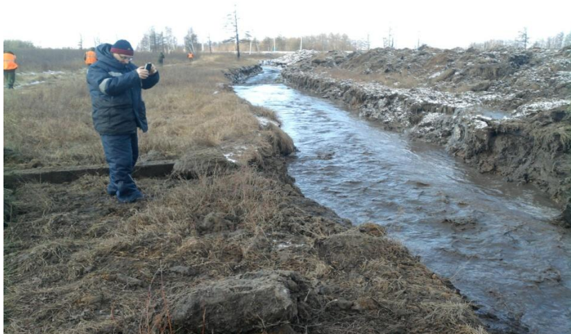
Рисунок 7 – Сброс воды по нагорному каналу под мост
