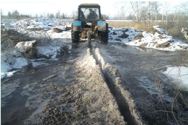
Рисунок 10 – Нарезка траншеи баровой машиной для установки противодиффузионного экрана
