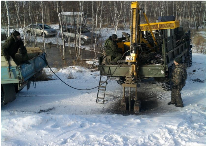
Рисунок 4 – Бурение скважин вдоль железнодорожной насыпи
