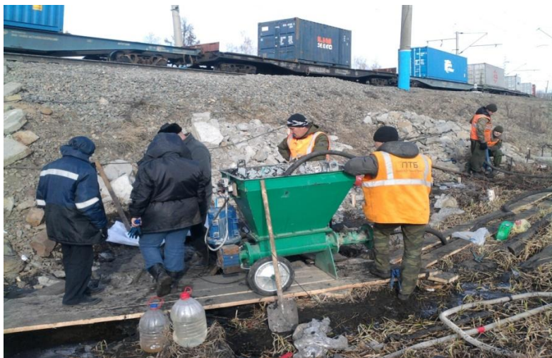
Рисунок 11 – Устройство противофильтрационного экрана вдоль насыпи
