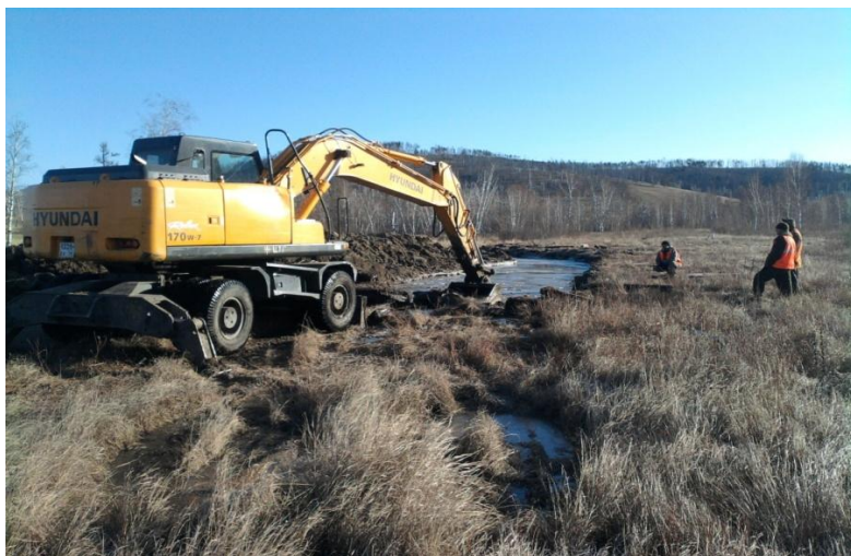
Рисунок 6 – Выемка грунта экскаватором по трассе нагорного канала
