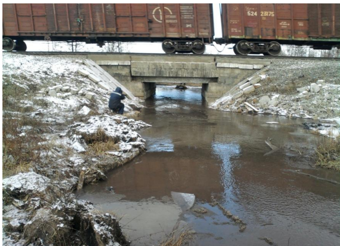
Рисунок 1– Общий вид железнодорожного моста на ПК 3+75
