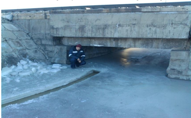
Рисунок 12 – Процесс наледообразования под железнодорожным мостом
