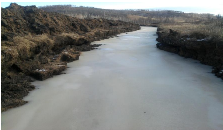
Рисунок 8 – Перехват потока воды ручья и отведение его по нагорному каналу в зимний период
