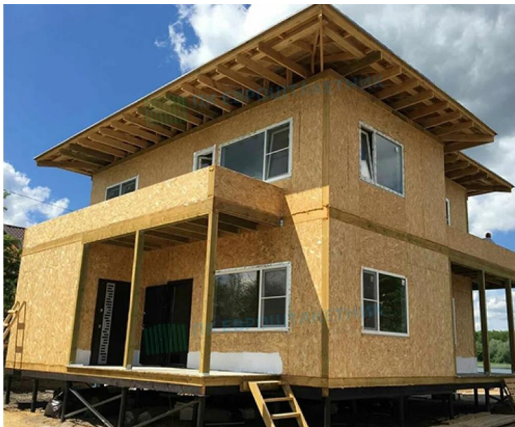
Рисунок 2– Пример дома из сип-панелей
