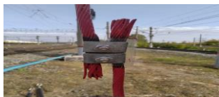
Рисунок 1 – Альтернативный импульсный промежуток
